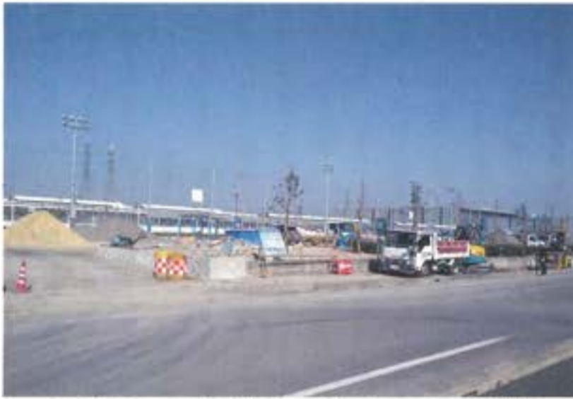
完成間近の、子ども遊戯場、グラウンドゴルフ場整備
